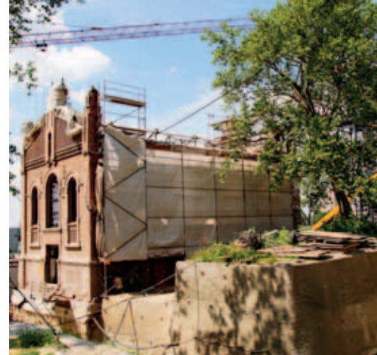
Ryc. 6. Widok obudowy wykopu przy chronionym platanie
