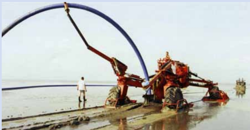
Instalacja przewodu wodociągowego na błotnistych równinach wybrzeża Morza Północnego
