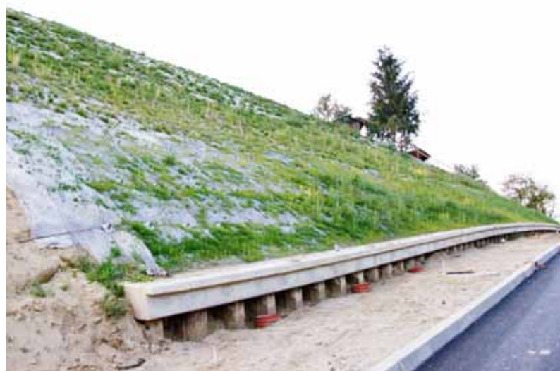
Widok skarp w trakcie realizacji prac zabezpieczających
