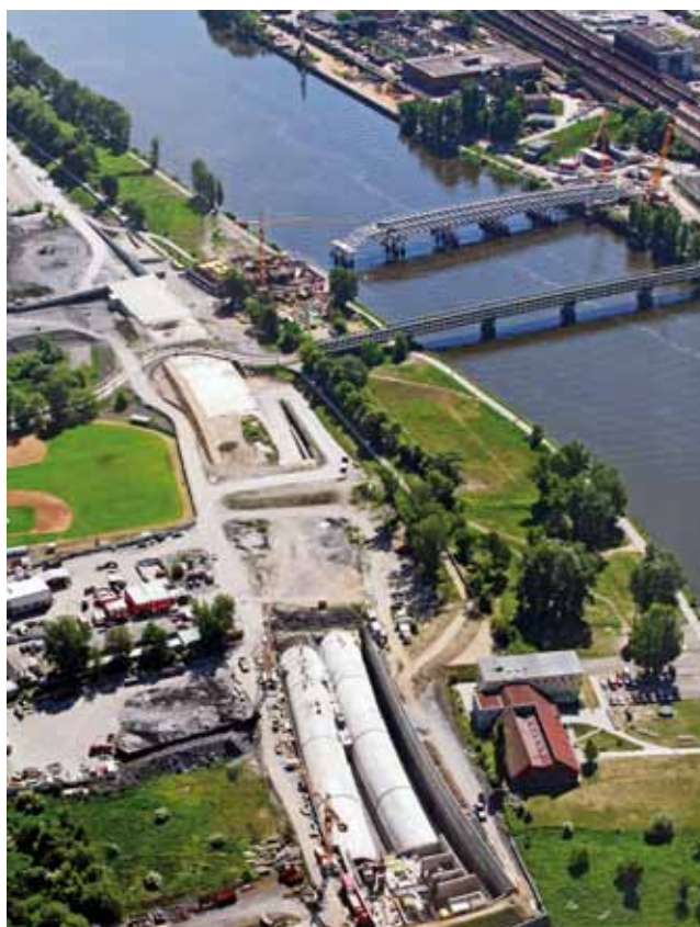
Tunele wykonane metodą odkrywkową oraz tunele sklepione na Triji
