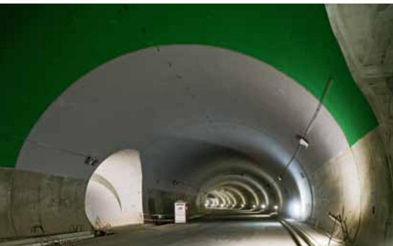
Tunele wykonane metodą górniczą, drążone na odcinku Špejchar – Pelc-Tyrolka
