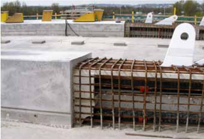
Ryc. 14. Ciężno łuku przed i po betonowaniu
