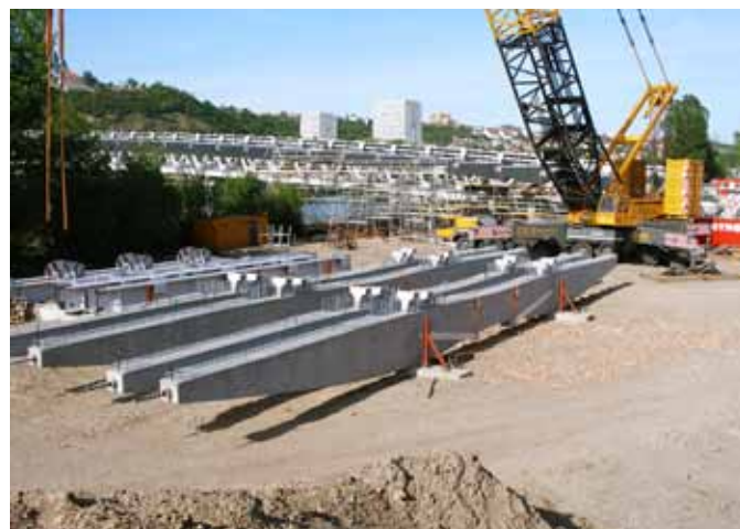
Ryc. 12. Poprzecznicę prefabrykowane na składzie
