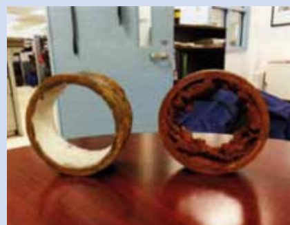
Inkrustracja przewodu wodociągowego
