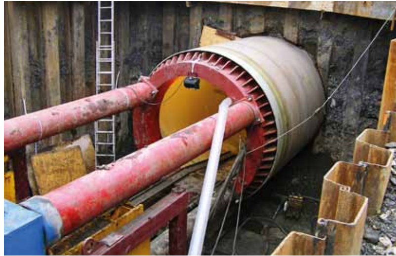
Wykop z zastosowaniem technologii bezwykopowej
