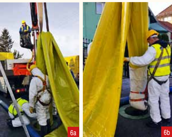
Ryc. 6a, 6b. Wprowadzenie do przewodu kanalizacyjnego nasączonej żywicą powłoki
