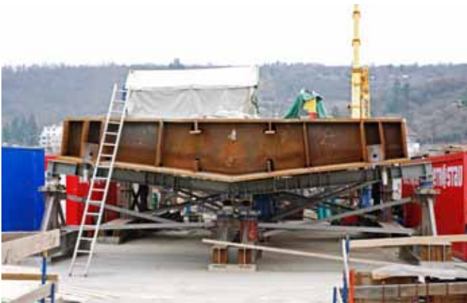
Ryc. 15. Przekrój łuku w części środkowej
