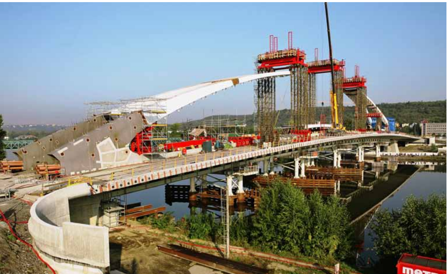
Ryc. 10. Stan robót po wzniesieniu obu części skrajnych łuku
