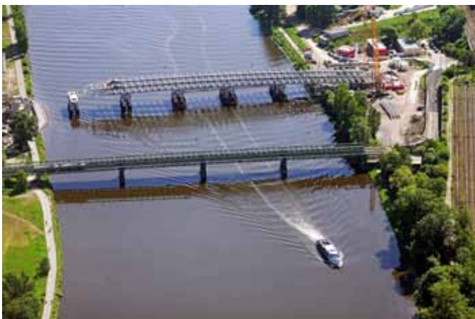
Ryc. 6. Widok wysuwanej konstrukcji z lotu ptaka
