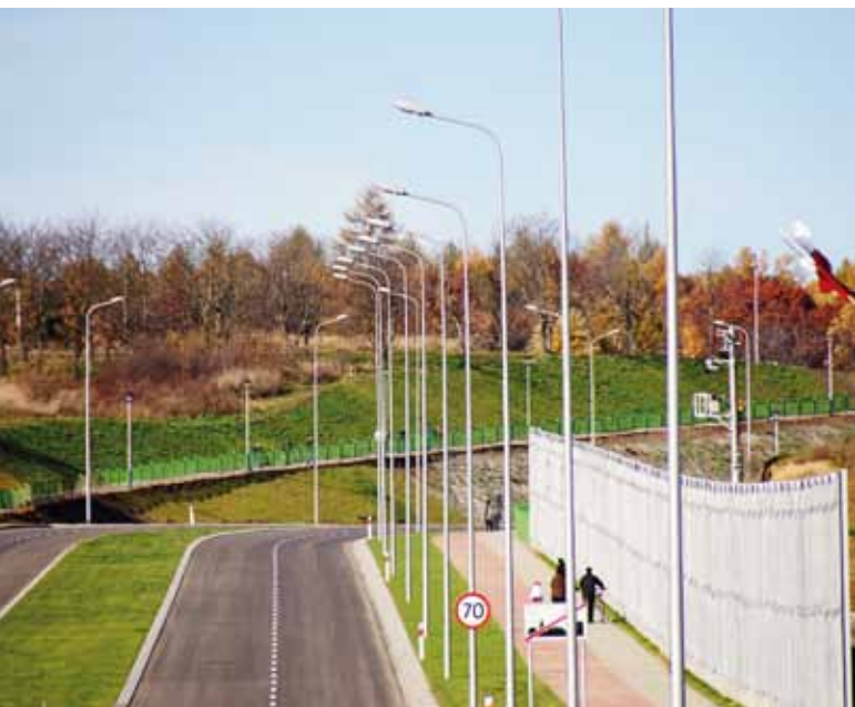
Widok zabezpieczonych skarp w dniu odbioru 10 listopada 2011 r.
