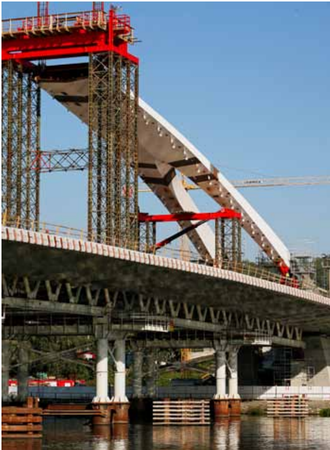
Ryc. 9. Wznoszenie skrajnej części łuku po stronie Troi
