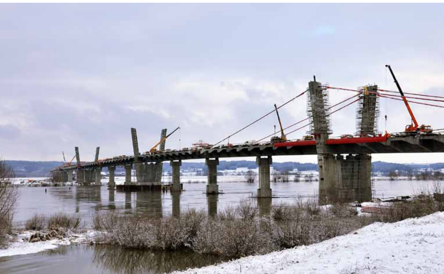
Montaż pierwszych want na moście głównym, luty 2013 r.
