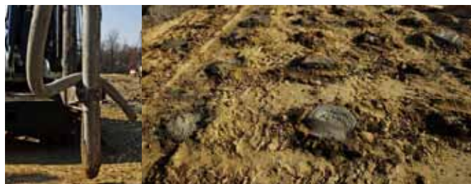
Ryc. 4. Zdjęcia z realizacji wzmocnienia w technologii MSC
