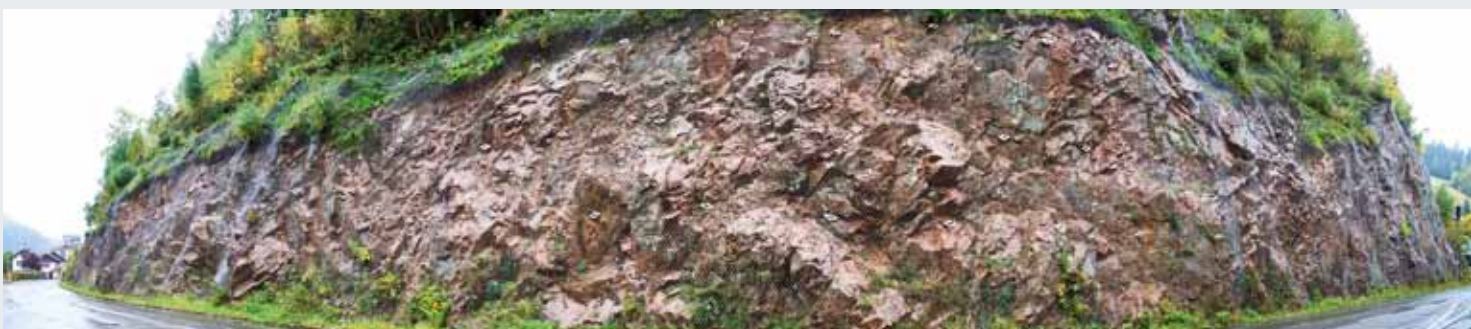
Stabilizacja siatką TECCO® ściany skalnej przy drodze krajowej L108, Lauterbach w Niemczech
