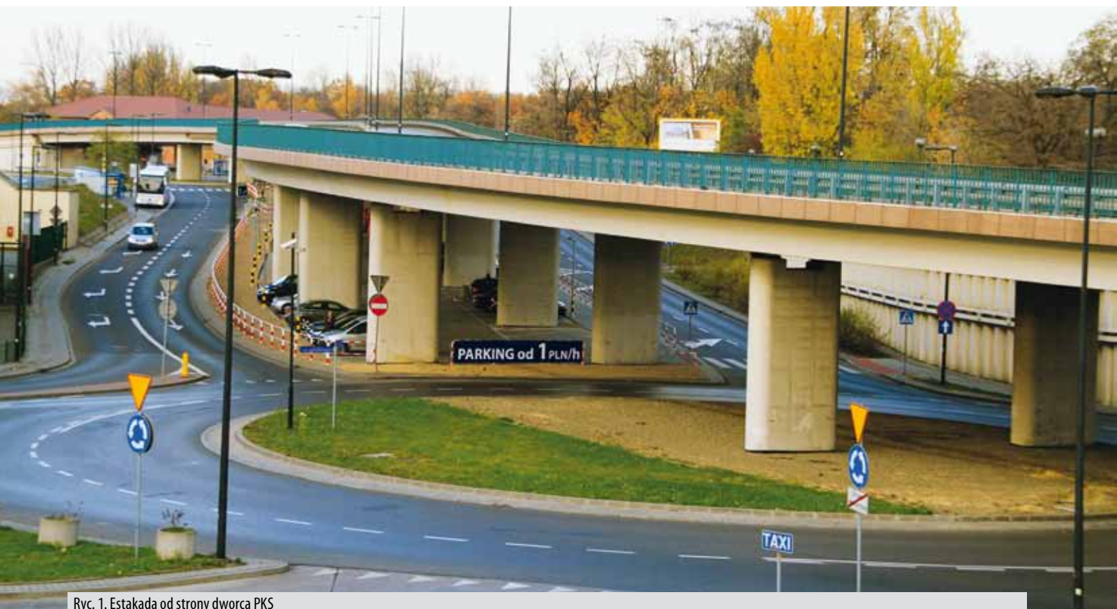
Ryc. 1. Estakada od strony dworca PKS
