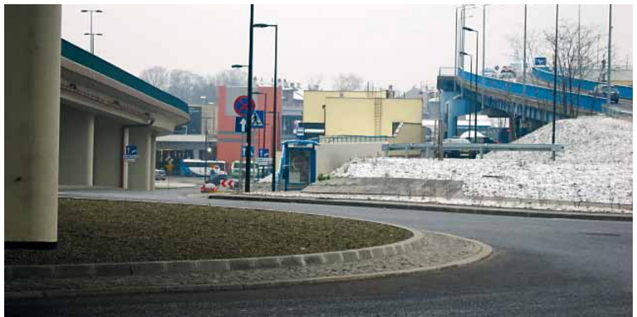
Ryc. 4. Rondo przy wjeździe na górny poziom (górną platformę) dworca PKS i parking nad peronami dworca PKP. Po prawej stronie estakada dojazdowa (kolor niebieski) na parking nad peronami dworca PKP. W tle budynki PKP i dworca PKS
