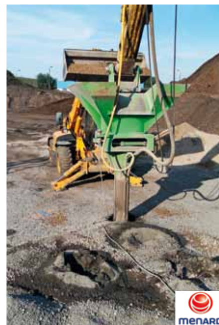
Ryc. 5. Wsypanie kruszywa do rury formującej stopę żwirową kolumn (obwodnica Elku), źródło: Menard Polska Sp. z o.o.
