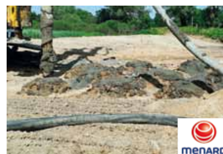
Ryc. 6. Wykonywanie trzonów betonowych kolumn z głowicą betonowo-żwirową, źródło: Menard Polska Sp. z o.o.
