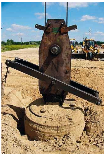
Ryc. 3. Formowanie kolumny wybijanej
