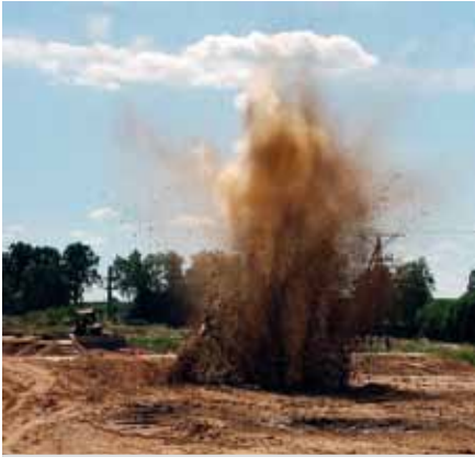
Ryc. 7. Wzmocnienie podłoża metodą mikrowybuchów, źródło: Polbud-Pomorze Sp. z o.o.
