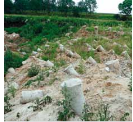
Ryc. 8. Połamane kolumny w wyniku przemieszczenia się mas słabego gruntu
