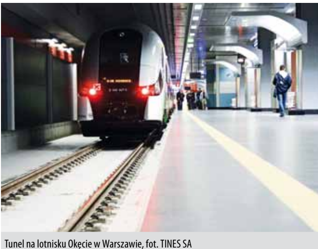
Tunel na lotnisku Okęcie w Warszawie, fot. TINES SA
