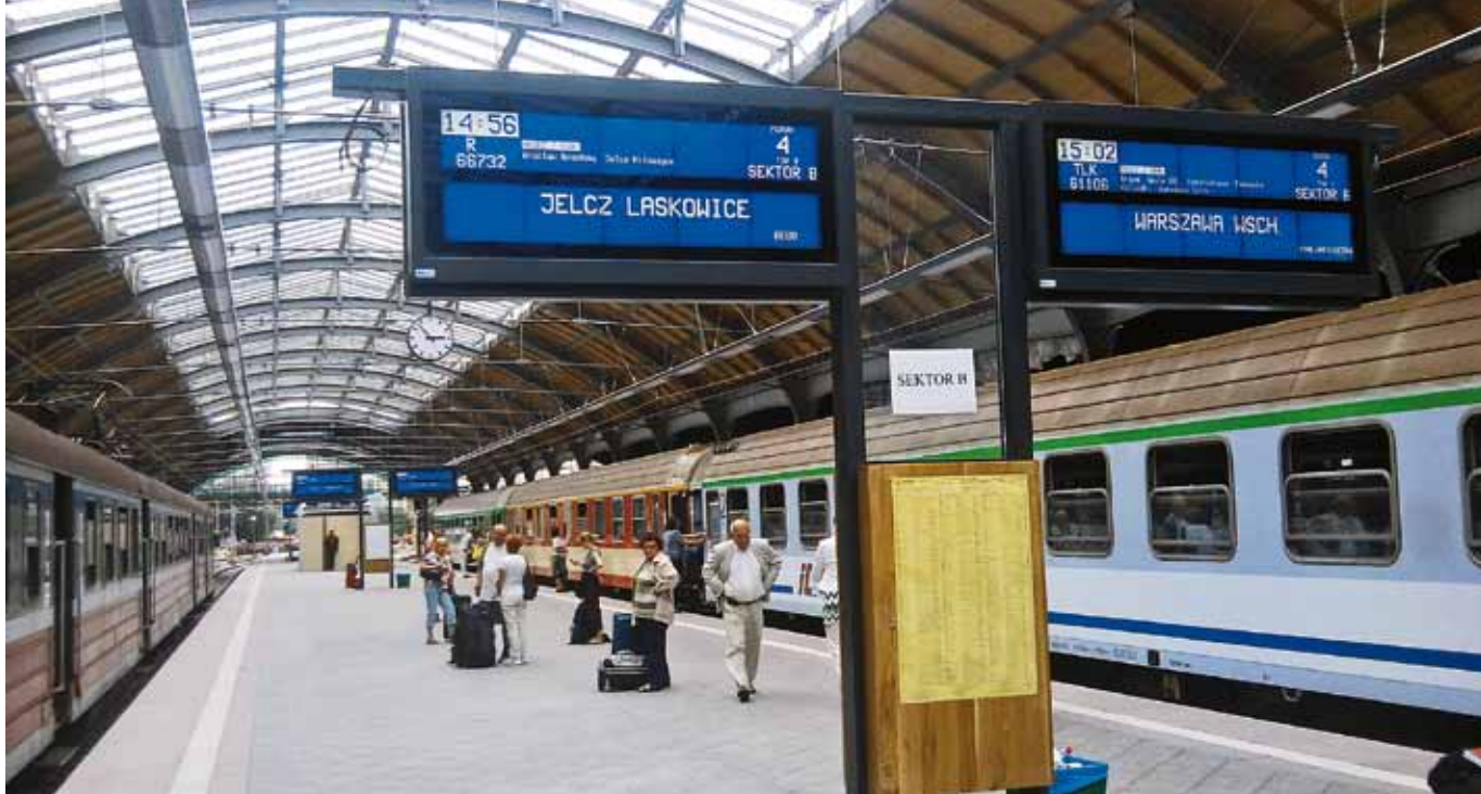
Tablice peronowe na nowym dworcu Wrocław Główny
