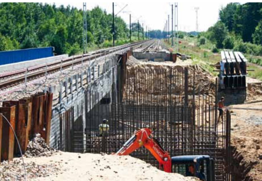
Modernizacja trasy Warszawa – Gdynia, fot. PKP PLK SA
