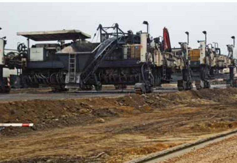
Zespół maszyn do układania nawierzchni betonowej SP1500 Wirtgen
