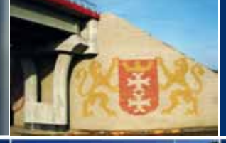
Źródło: Autostrada Wielkopolska SA
