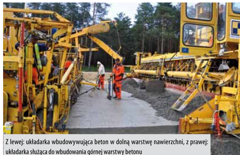
Układarka do betonu w trakcie wbudowywania dolnej warstwy betonu (nawierzchnia betonowa składa się z dwóch warstw dolnej oraz górnej, wykonywanej w technologii na mokro)
