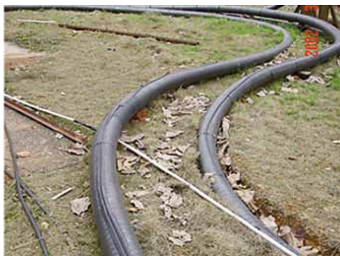
Ryc. 2. Układanie światłowodów
