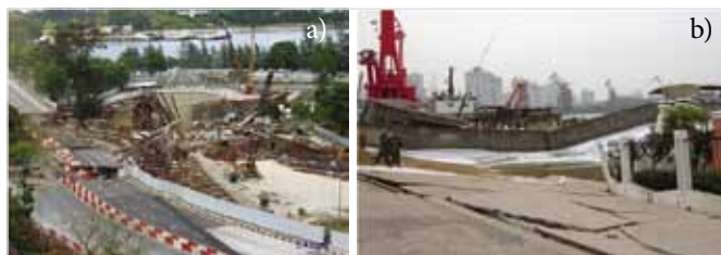
Ryc. 1. Dwa typowe przypadki awarii spowodowanych drążeniem tunelu: a) katastrofa na autostradzie Nicole w Singapurze, b) awaria na czwartej linii metra w Szanghaju
