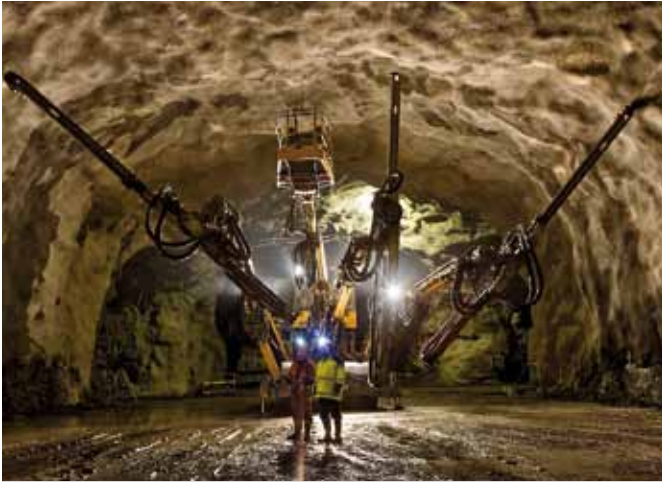
Prace podziemne prowadzone w ramach projektu Citybanan
