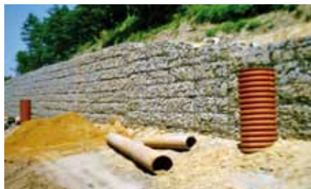
Ryc. 7. Zabezpieczenie stoku gabionami
