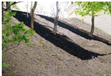
Ryc. 10. Zabezpieczenie zbocza w systemie geokomórkowym
