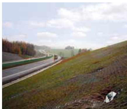
Ryc. 11. Zabezpieczenie powierzchniowe systemem Tecco
