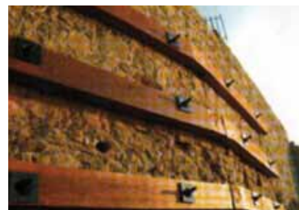
Ryc. 12. System Titan zastosowany do konstrukcji oporowych
