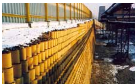
Ryc. 9. Mur oporowy wykonany w systemie geokomórkowym
