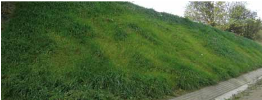
Ryc. 20. Zabezpieczenie skarpy metodą hydroobsiewu
