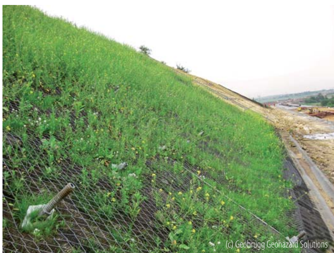
Autostrada A1, stabilizacja skarp z wykorzystaniem systemu TECCO
