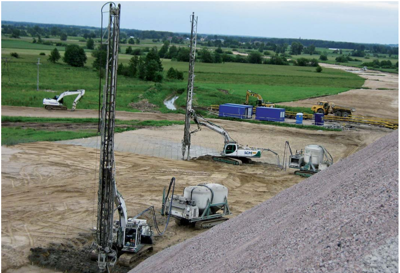
Ryc. 1. Wykonywanie kolumn DSM-d pod nasypą drogi krajowej S7
