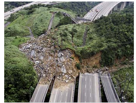
Ryc. 6. Osuwisko na autostradzie
