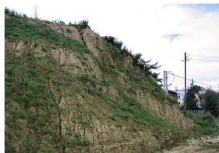
Ryc. 4. Spękane zbocze masywu gruntowego
