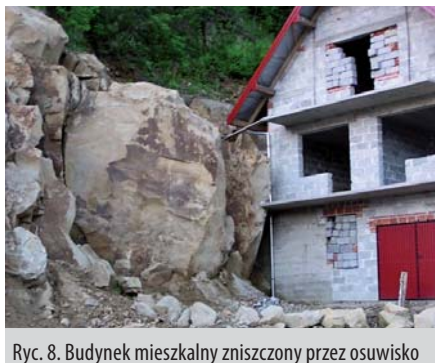
Ryc. 8. Budynek mieszkalny zniszczony przez osuwisko
