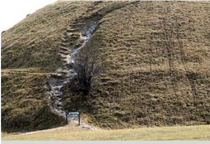
Ryc. 2. Erozyjne działanie wody pochodzącej z roztopów na zboczach kopca
