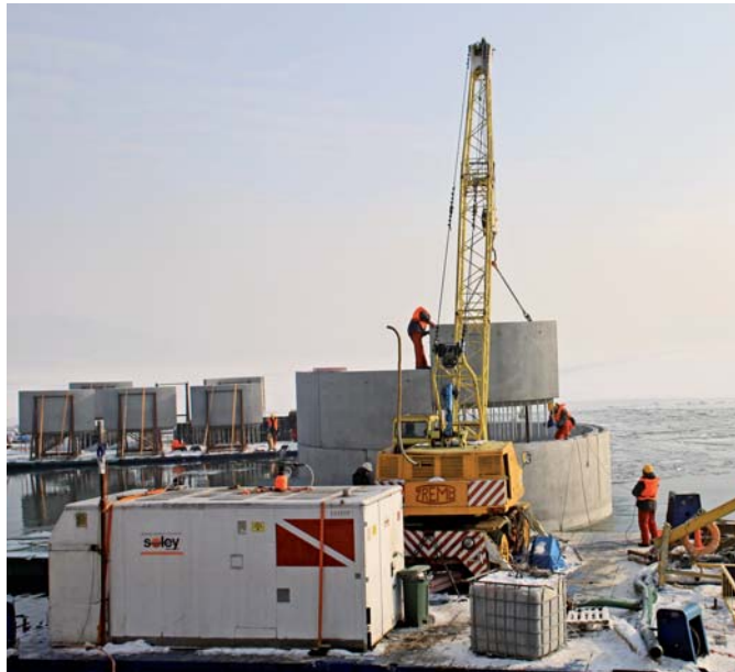
Montaż prefabrykatów
