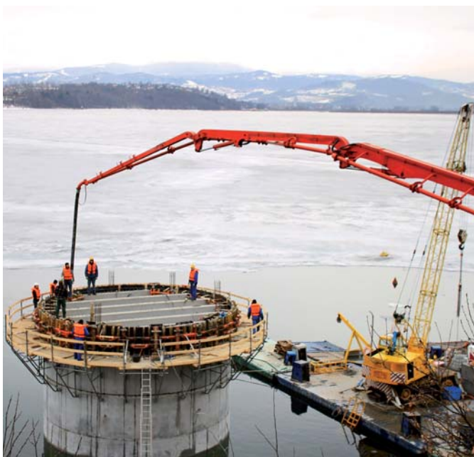
Betonowanie stropu
