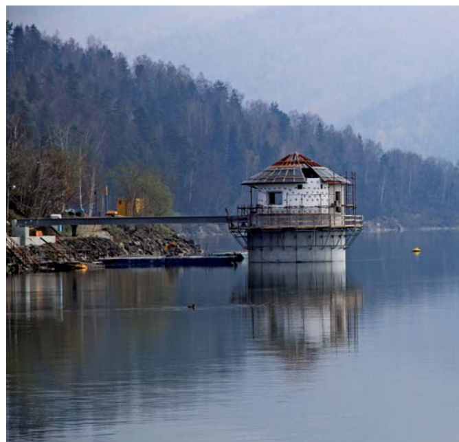
Montaż elementów stalowych kładki
