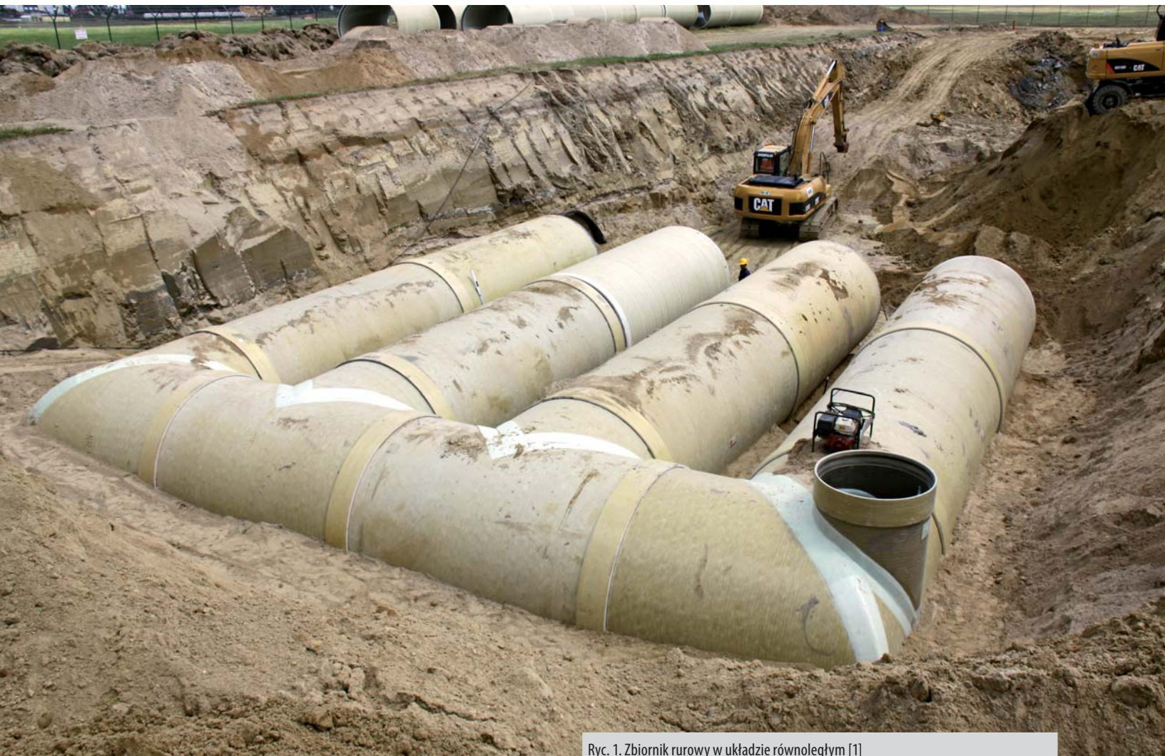
Ryc. 1. Zbiornik rurowy w układzie równoległym [1]
