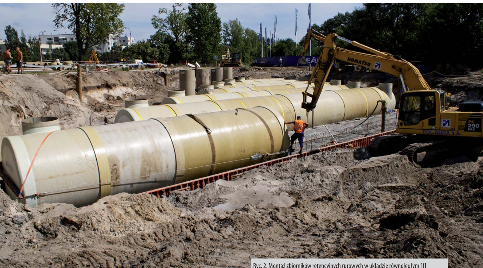
Ryc. 2. Montaż zbiorników retencyjnych rurowych w układzie równoległym [1]
