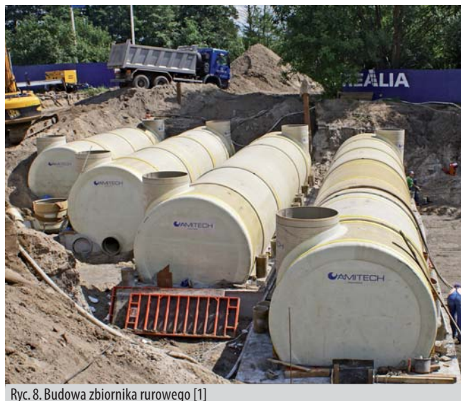
Ryc. 8. Budowa zbiornika rurowego [1]
