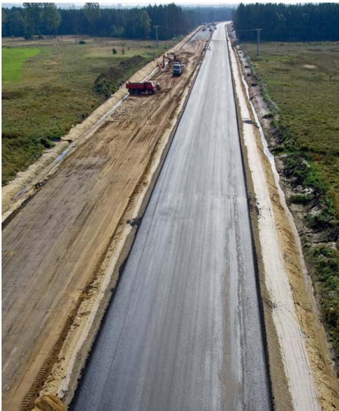
Fragment nawierzchni na odcinku pomiędzy wiaduktem w ciągu DK78 nad ul. Krakowską (w km 3 + 121,97) a wiaduktem w ciągu DK78 nad drogą gruntową (w km 4 + 897,06)
