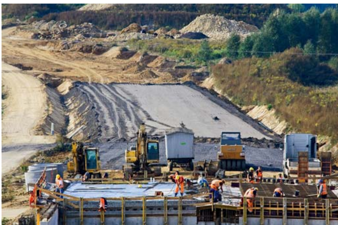
Wiadukt nad ul. Relaksową
