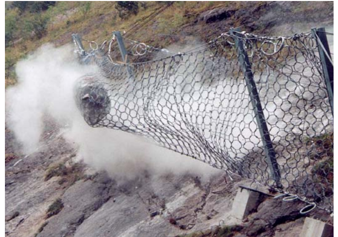
Ryc. 2. Bariera odłamkowa w trakcie uderzenia. Znakomicie widoczna praca wszystkich elementów oraz „elastyczność” konstrukcji
