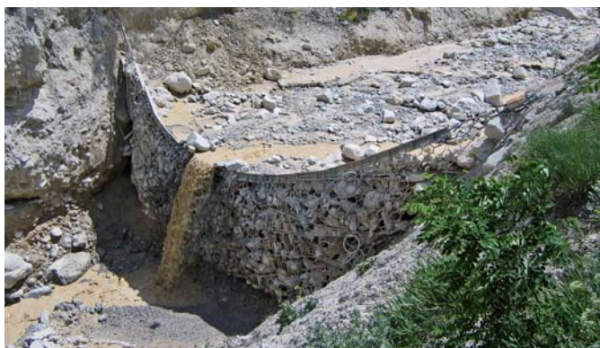
Ryc. 8. Bariera gruzowa po zatrzymaniu spływu gruzowego
