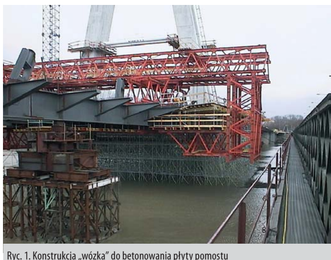
Ryc. 1. Konstrukcja „wózka” do betonowania płyty pomostu
