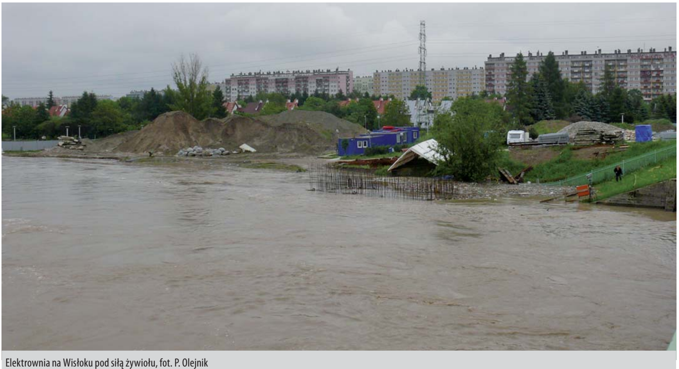
Elektrownia na Wisłoku pod siłą żywiołu, fot. P. Olejnik
