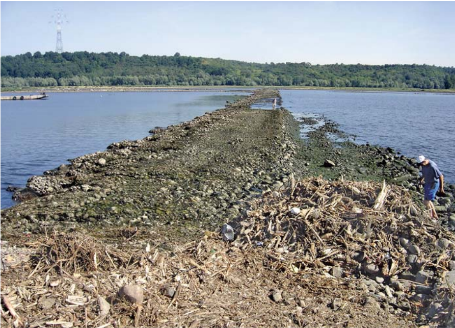
Prowizoryczny próg poniżej zapory we Włodawku, który ma podpiętrzać dolne stanowisko stopnia. Po lewej – przy niskich stanach wody, po prawej – przy pracy elektrowni. Ani w jednym, ani w drugim przypadku żegluga nie jest możliwa, a śluza na stopniu jest od wielu lat praktycznie beзуżyteczna, fot. D. Sołtys
