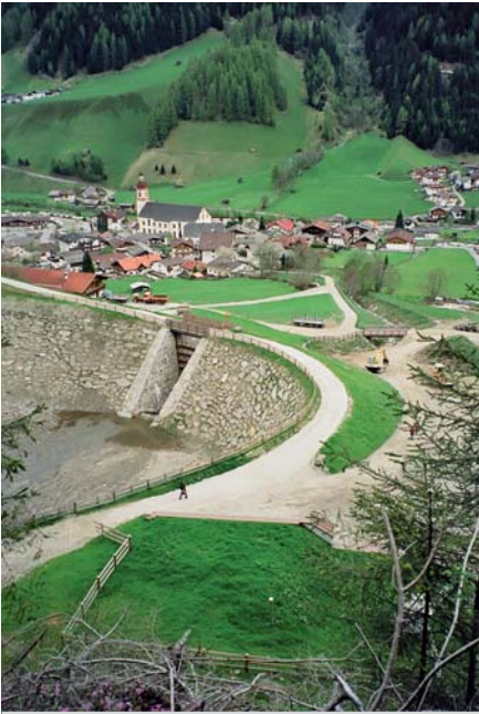
Mały, suchy zbiornik przeciwpowodziowy na niewielkim potoku górskim, na zboczu alpejskiej doliny Stubai w Austrii. Po lewej, widok ogólny, po prawej szczegół umocnienia skarp zbiornika – między głazami umieszczono żywe rzasy wierzby, która porośnie skarpy i „wkomponuje” ten obiekt w krajobraz, fot. Z. Kledyński
