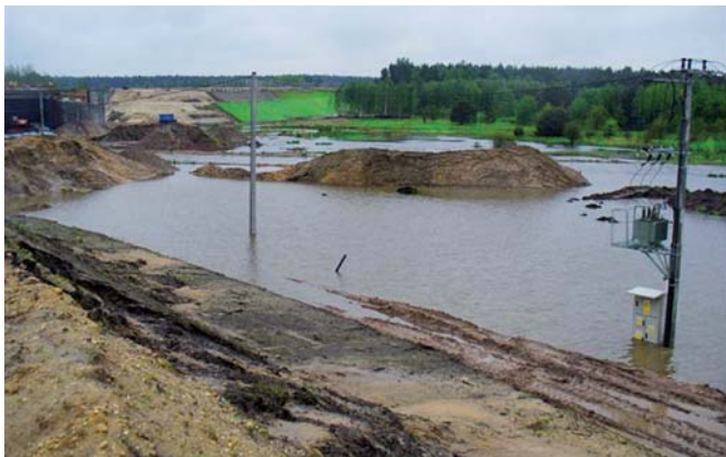
A1 Bełk – Świerklany, fot. GDDKiA oddział w Katowicach
