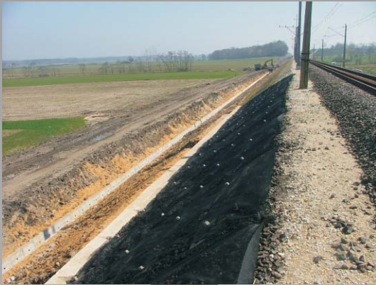
Wzmocnienie nasypu kolejowego Linia E 30
