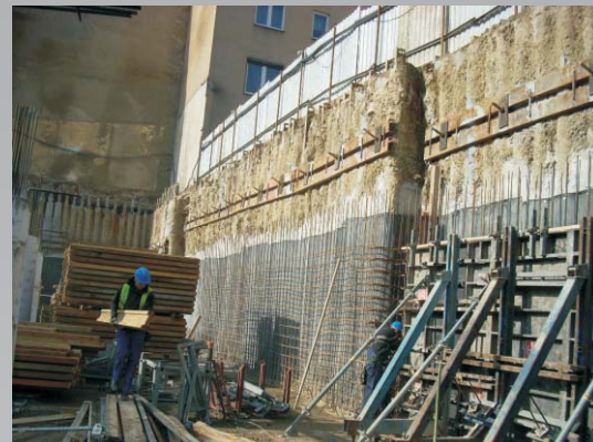
Zabezpieczenie głębokiego wykopu Filharmonia, Kielce
