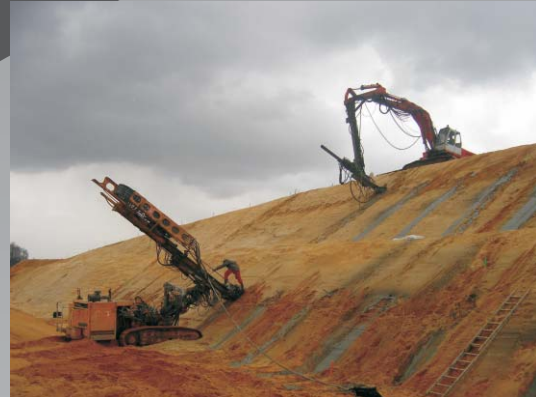
Zabezpieczenie skarp wykopu Autostrada A1
