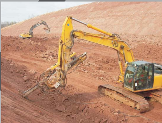
Zabezpieczenie skarp wykopu Droga ekspresowa S 7
