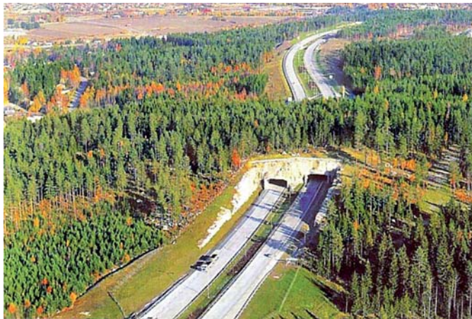
Ryc. 3. Tunel na autostradzie w Finlandii nie zakłóca migracji zwierząt i sukcesji roślinności
