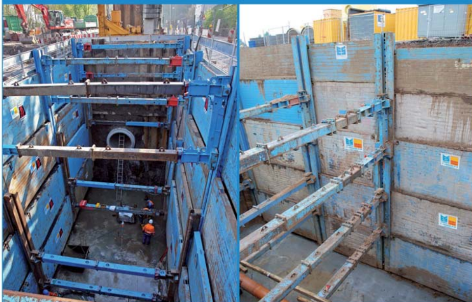
Obudowy do wykopów o głębokości do 14 m
