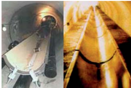
Ryc. 9. Wymiennik w systemie Rabtherm przed i po ustabilizowaniu go betonem [2]
