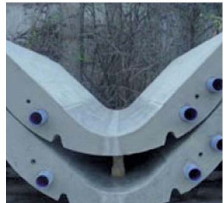
Ryc. 13. Prefabrykaty betonowe z wbudowanym wymiennikiem ciepła zastosowane w Leverkusen
