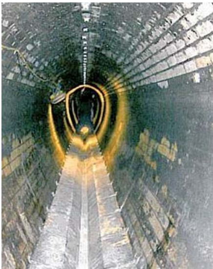
Ryc. 8. Wymiennik ciepła w systemie Therm Liner wbudowany w kanał o przekroju jajowym [2]
