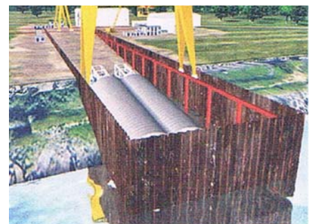
Ryc. 9. Ustawienie urządzenia TIMBY w koferdamie, na brzegu przeszkody wodnej [1]
