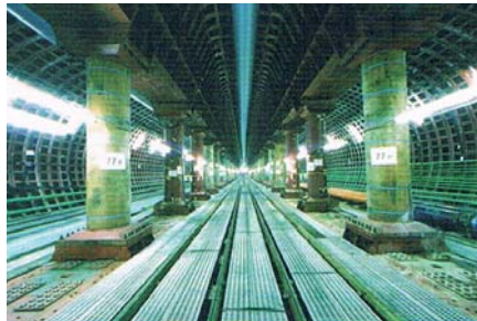
Ryc. 2. Tunel stacji metra Iidabashi wbudowany wielokołowym urządzeniem tarczowym [6]
