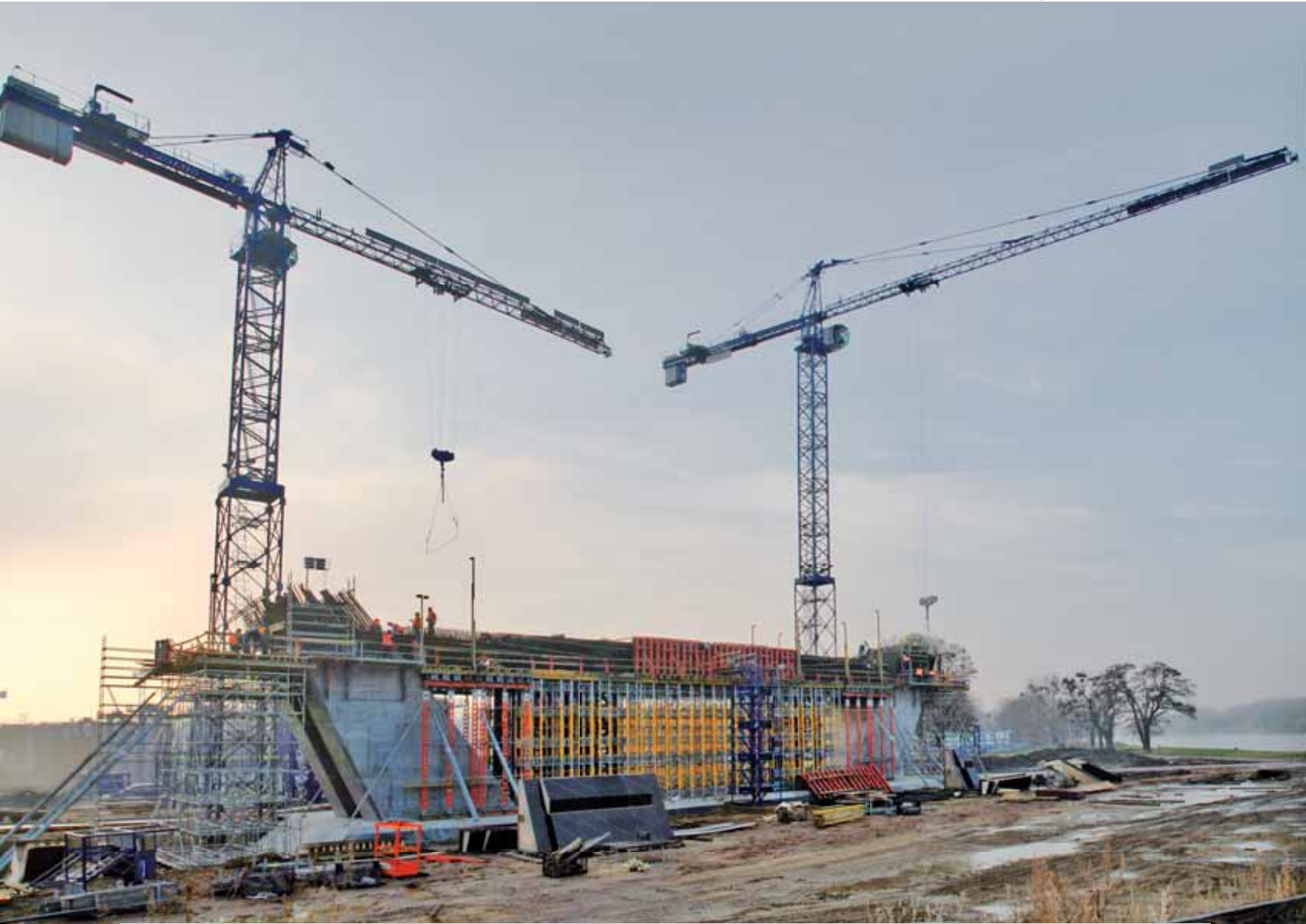
Betonowa konstrukcja mostu Rędzińskiego zostanie zawieszona na jednym 122-metrowym pylonie. Będzie to najwyższa tego typu konstrukcja w Polsce. Projektantem mostu jest Jan Biliszczuk
