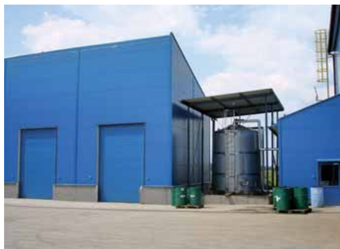
Część inwestycji: magazyn odpadów stałych i zbiornik na odpady płynne niebezpieczne
