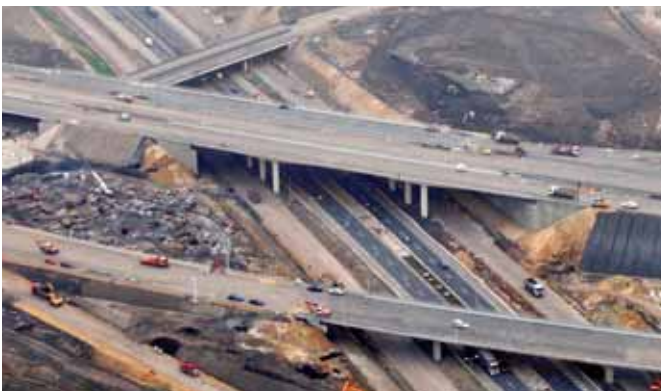
Ryc. 6. Wiadukt WA-466.2 w km 517 + 980,04 – ostatni etap robót pozwalających na uruchomienie węzła
