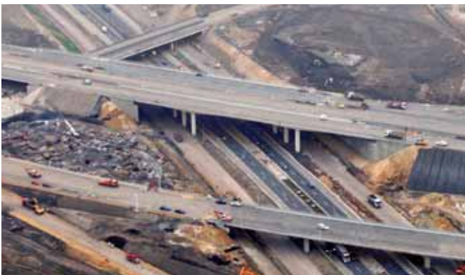
Ryc. 6. Wiadukt WA-466.2 w km 517 + 980,04 – ostatni etap robót pozwalających na uruchomienie węzła
