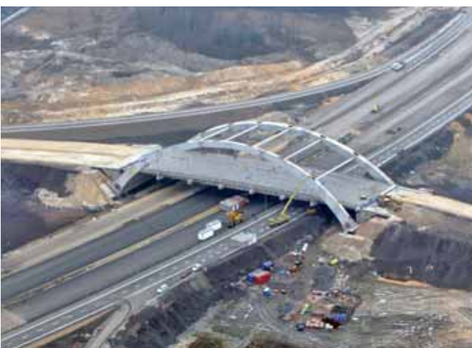
Ryc. 8. Wiadukt w ciągu łącznicy G1 nad A1 – widok z boku od strony południowej
