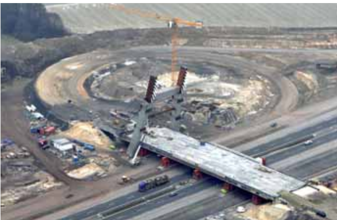
Ryc. 7. Pochylony pylon wiaduktu WD-467a nad A4 (w ciągu łącznicy G1)
