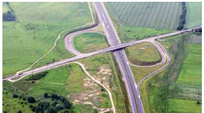
Ryc. 1. Rejon budowy przed rozpoczęciem robót
