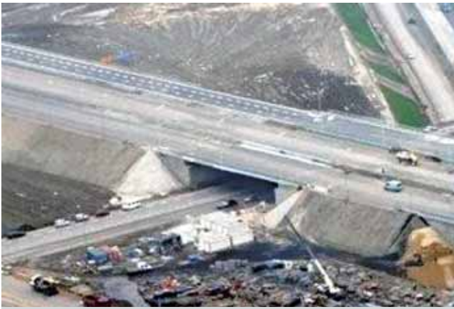
Ryc. 5. Wiadukt WA-466.1 nad DK 44 w trakcie robót wykończeniowych
