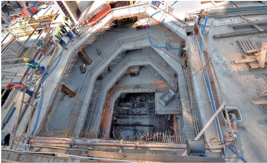
Budynek Biurowy Wolf Marszałkowska w Warszawie
