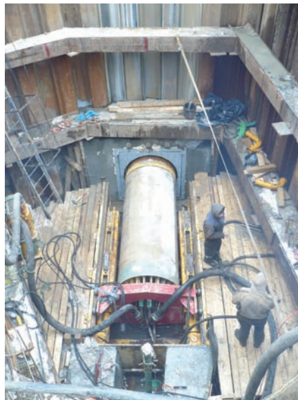
Rura kanalizacyjna przed i po wciśnięciu do gruntu
