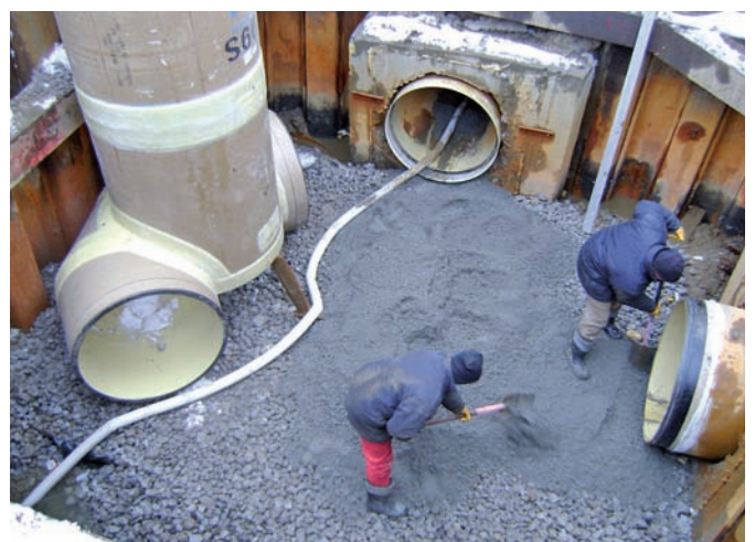
Montaż studzienki kanalizacyjnej w miejscu zmiany kierunku kolektora
