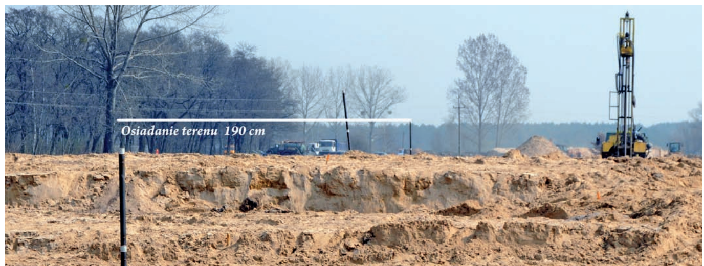
Ryc. 3. Osiadanie gruntu uzyskane natychmiast po seriach strzałowych
