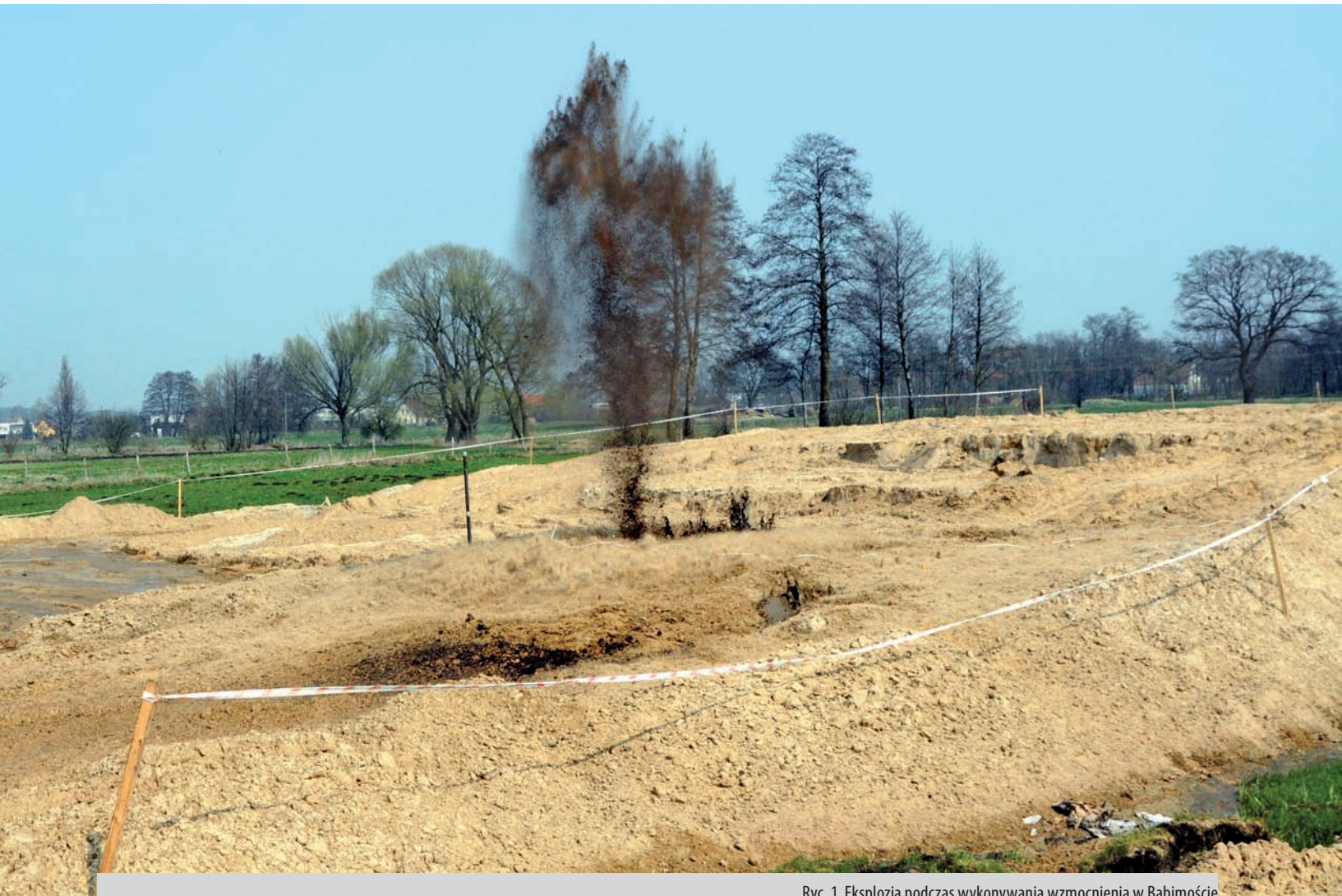
Ryc. 1. Eksplozja podczas wykonywania wzmocnienia w Babimoście
