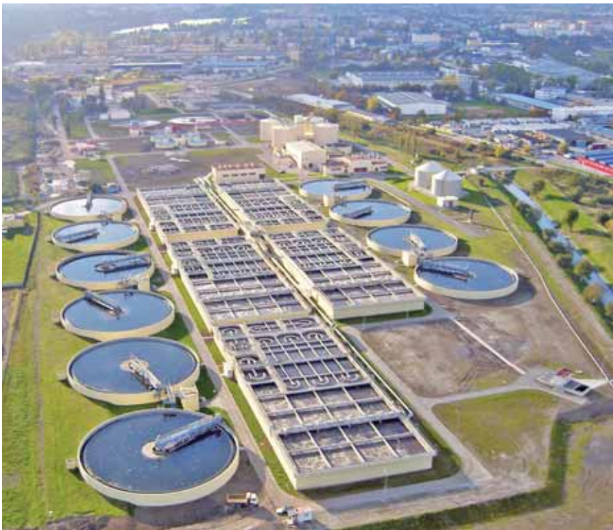
Oczyszczalnia Ścieków Kraków-Płaszów, fot. archiwum PBG SA
