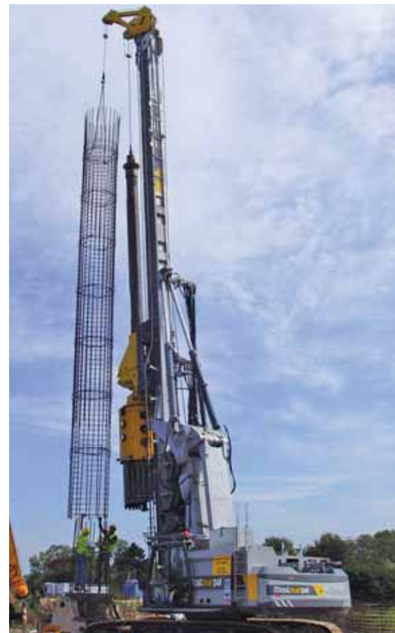
Palowanie przez zaprzyjaźnioną firmę MOSTMARPAL Sp. z o.o.
