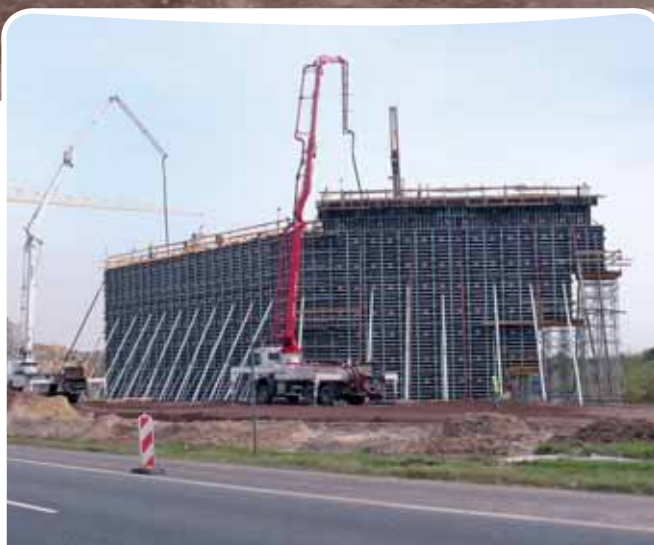
Deskowanie przyczółka, fot. Hünnebeck Polska
