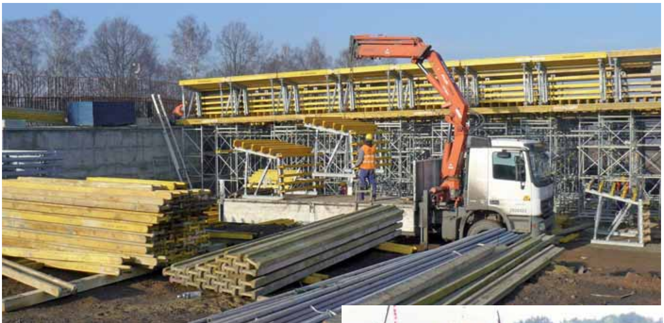
Montaż elementów SG, fot. Hünnebeck Polska
