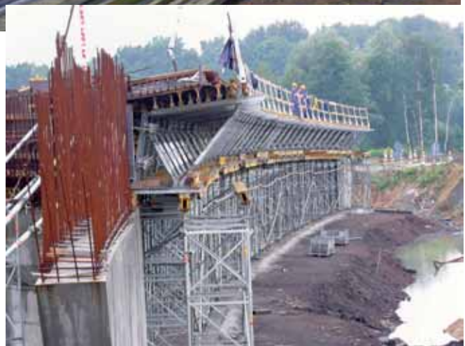
Deskowanie ustroju nośnego, fot. Hünnebeck Polska
