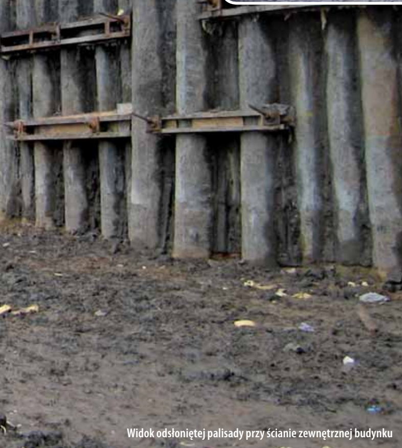
Palisada zabezpieczająca wykop od strony ul. Jana Pawła II
