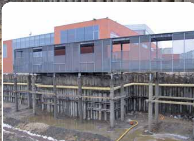
Tymczasowy ciąg komunikacyjny do istniejącej galerii na palach
