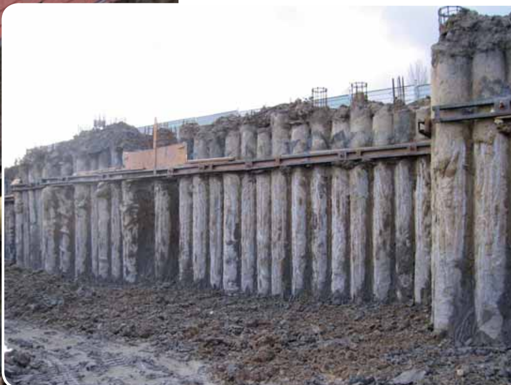
Palisada zabezpieczająca wykop od strony ul. Jana Pawła II
