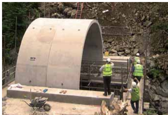
Ryc. 9. Montaż betonowych prefabrykatów do budowy obiektów inżynierskich o przekroju łukowym, fot. Freyssinet Polska
