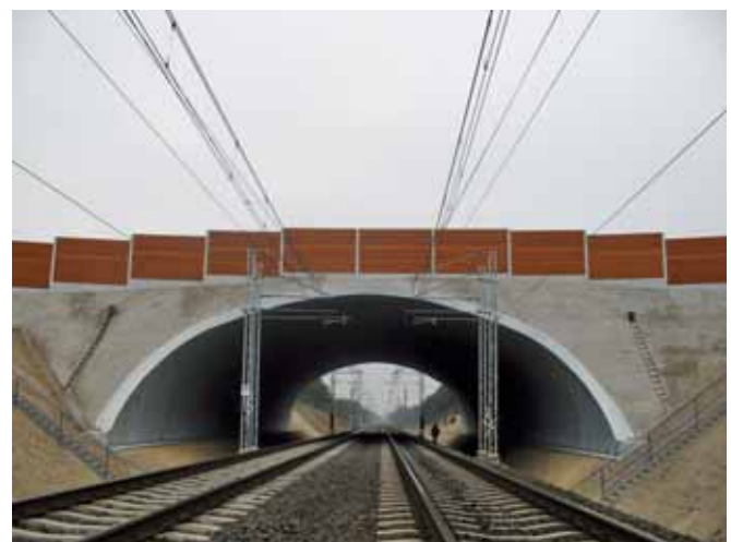
Ryc. 4. Ukończone przejście dla zwierząt nad linią kolejową E20
