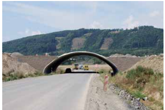
Ryc. 3. Obiekt pod autostradą D47 w Czechach (w trakcie realizacji)
