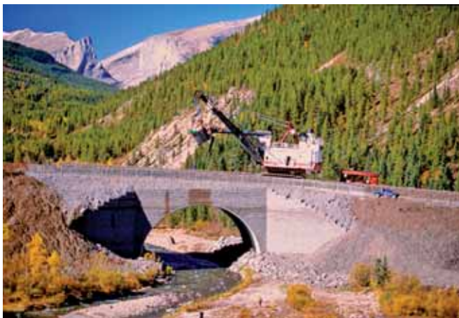
Ryc. 2. Największy na świecie obiekt zbudowany w Kanadzie
