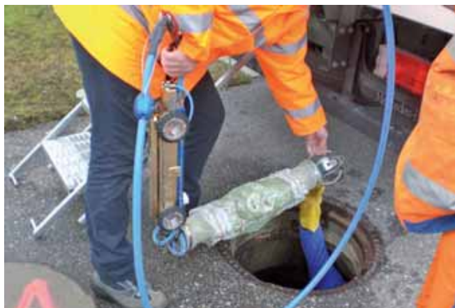
Technologia TopHat – Cosmic – wprowadzanie do kanału
