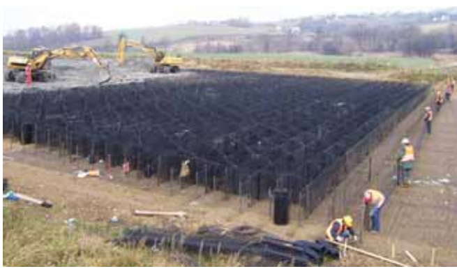
Ryc. 7. Wzmocnienie podstawy nasypu matercem geokomórkowym na obojściu Grodzca, fot. J. Alenowicz
