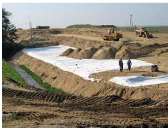
Ryc. 6. Wzmocnienie nasypu warstwami geotkaniny, fot. J. Alenowicz
