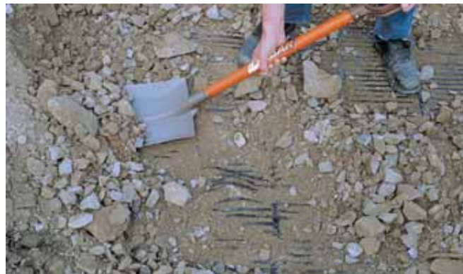
Ryc. 13. Odkopywanie próbki georusztu do oceny wpływu zagęszczania kruszy- wa na wytrzymałość, fot. Tensar International
