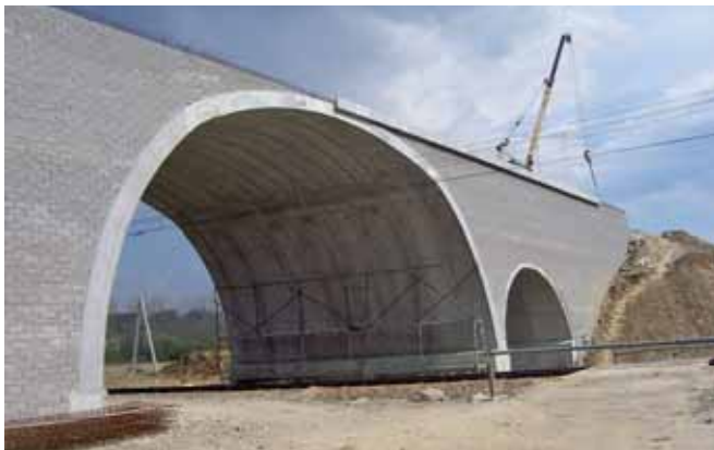
Ryc. 12. Ściana oporowa z gruntu zbrojonego z oblicowaniem z drobnowymiary- wych bloczków betonowych systemu Tensar Wall, fot. J. Alenowicz
