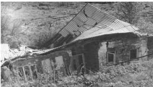
Skutki osuwiska w Lachowicach
