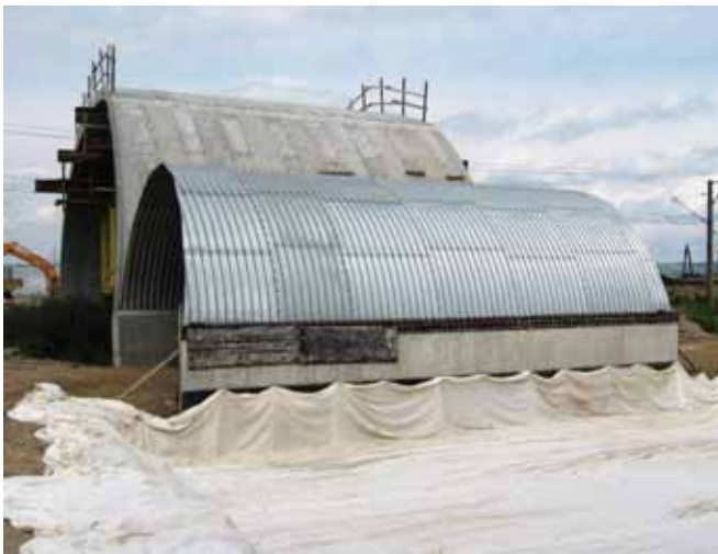
Geotkanina wzmacniająca podstawę konstrukcji
