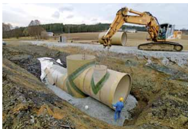
Montaż zbiornika retencyjno-odciążającego z rur Flowtite na kanalizacji ogólnospławnej
