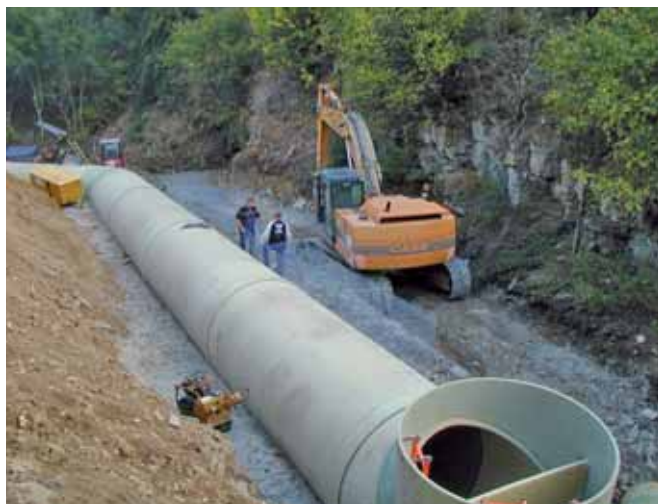
Budowa zbiornika retencyjnego w układzie liniowym na bazie rur Flowtite
