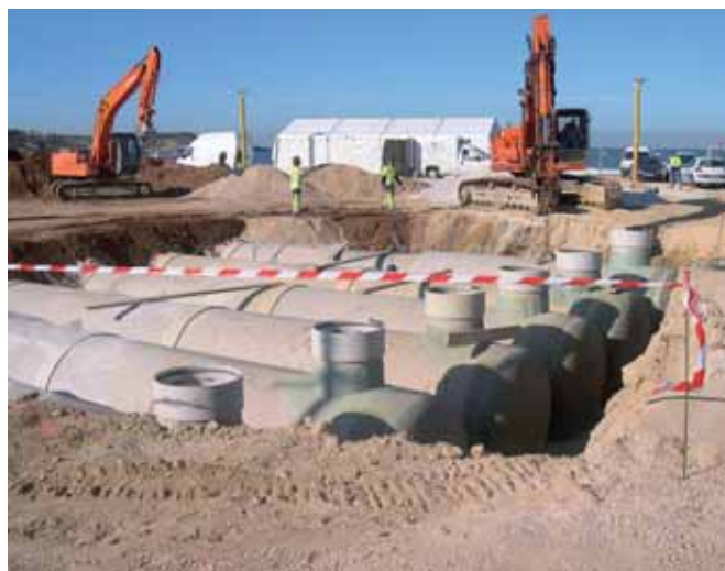
Zbiorniki retencyjne w układzie równoległym montowane na bazie rur Flowtite
