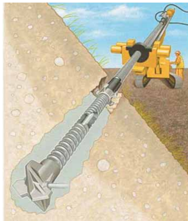
Ryc. 2. Wykonawstwo specjalnych robót geotechnicznych – gwoździe gruntowe
