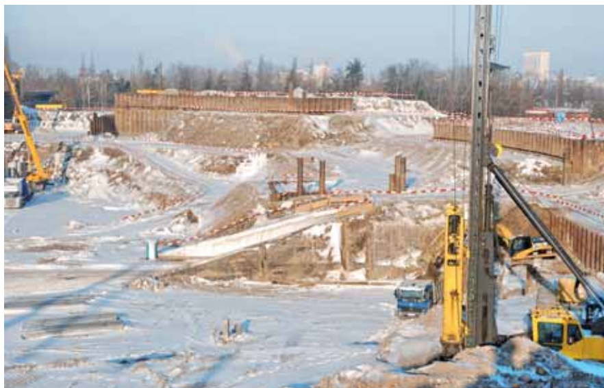
Wyjazd z istniejącego, zachowanego tunelu. Z prawej strony na pierwszym planie kafar do wbijania pali prefabrykowanych, fot. archiwum NCS
