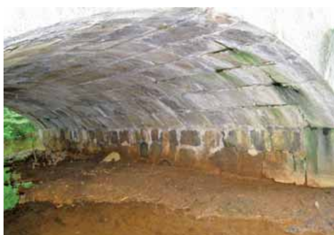
Ryc. 5. Przykładowy przepust pod drogą krajową, który okresowo, przy niskich stanach wód służyć może jako przejście dla zwierząt [1]
