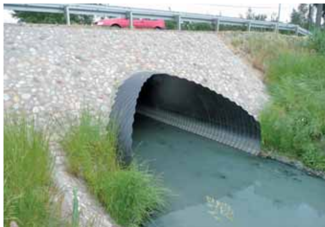
Ryc. 6. Przepust drogowy bez możliwości migracji zwierząt, fot. A. Wysokowski
