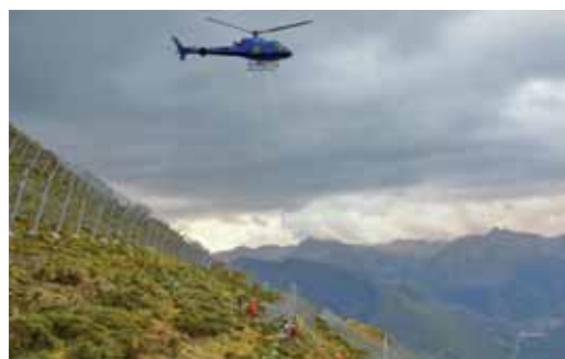
Ryc. 5. Instalacja barier śnieżnych przy wykorzystaniu helikoptera
