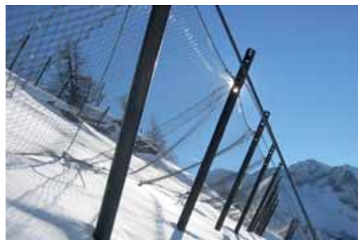
Ryc. 3. Widok konstrukcji barier śnieżnych
