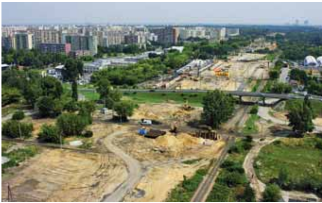
Budowa S8 w rejonie ul. Powstańców Śląskich
