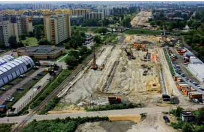
Budowa ścian szczylinowych w rejonie ul. Siodlarskiej i Powstańców Śląskich
